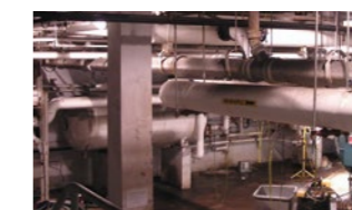
Čerpání vody ze sklepů
